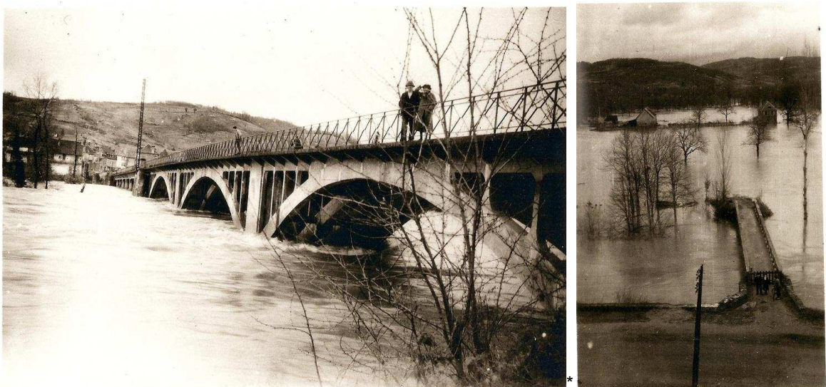
Fig. 11. Inondations au pont de Beaulieu et sur l'île Duchamp- 17 décembre 1952
